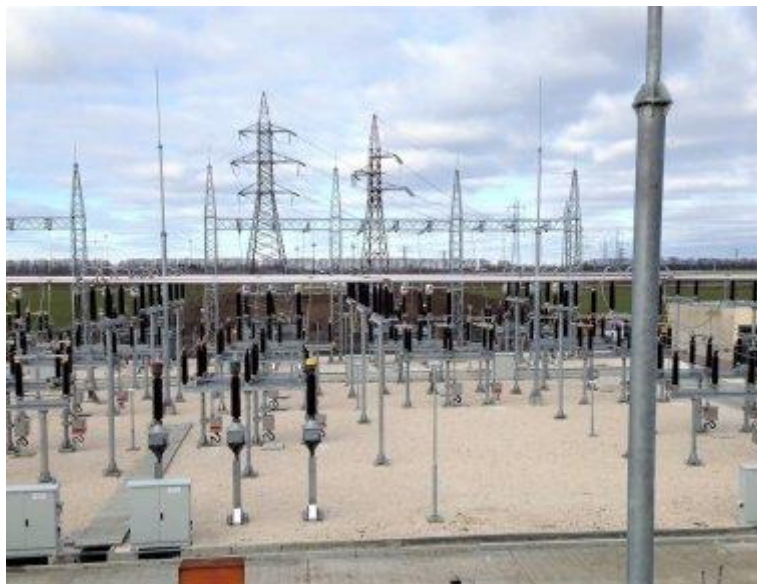
Фигура 4 Примерен изглед на подстанция 33/110 kV
