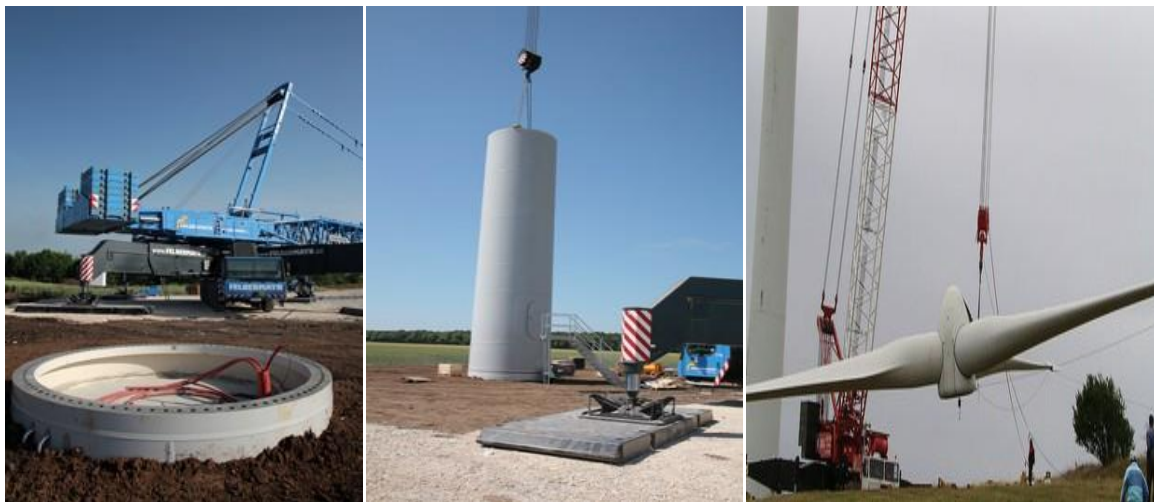
Фигура 9 Примерна на строително-монтажните работи
